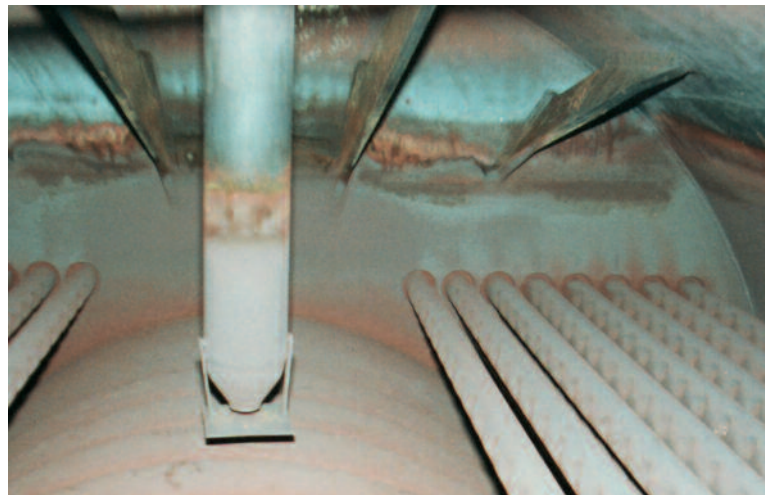
Großwasserraumkessel unter Verwendung von FINEAMIN®
