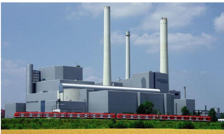
Bild 3. Mit Inbetriebnahme des Blocks II im HKW Nord im Jahr 1991 wurden die HD-Blöcke Süd überwiegend für Reservehaltung eingesetzt, mit häufigen An- und Abfahrvorgängen
