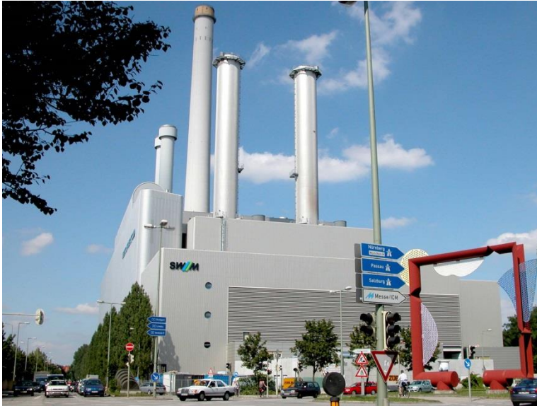
Bild 2. Im HKW München-Süd wurden die beiden Hochdruckblöcke IV und V (540 °C, 200 bar) in Grundlast zur Strom- und Fernwärmeversorgung gefahren; verwendet wurde vollentsalztes Wasser mit Zusatz von Hydrazin
